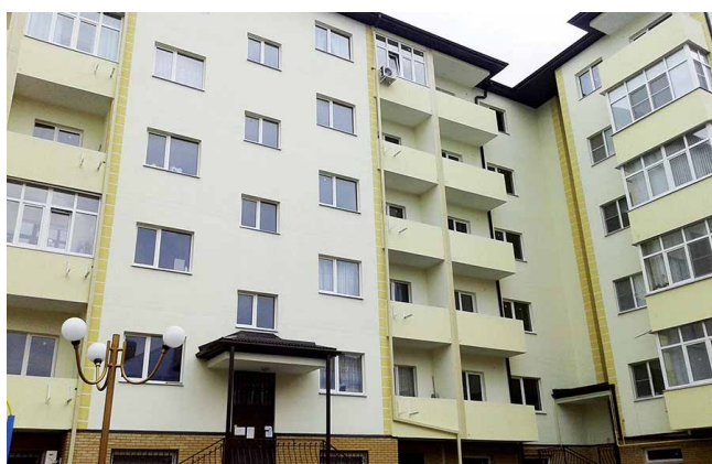
Жилой дом, г. Краснодар Общая мощность котельной — 460 кВт
