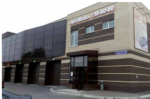
Автосервис, г. Йошкар-Ола Общая мощность котельной — 500 кВт
