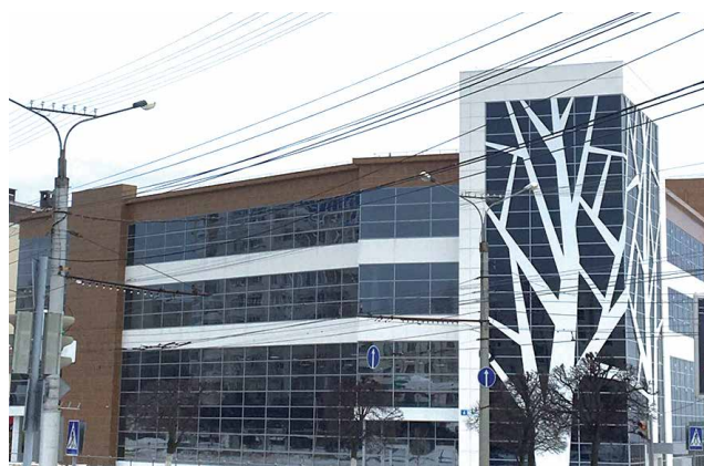
МФЦ, г. Чебоксары Общая мощность котельной — 1 МВт
