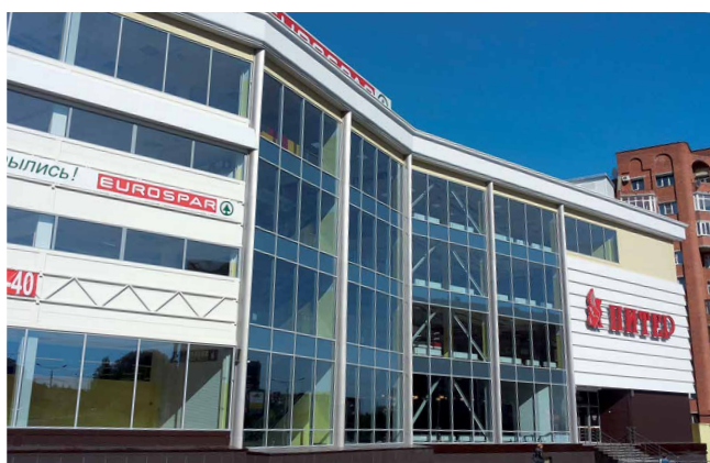
ТЦ «Питер», г. Чебоксары Общая мощность котельной — 600 кВт
