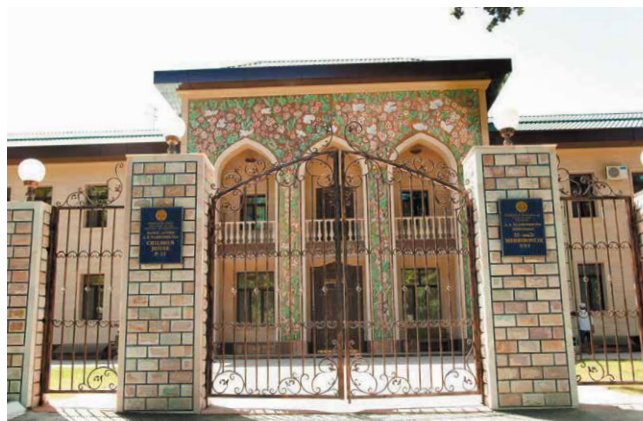
Интернат им. А.П. Хлебушкиной, г. Ташкент Общая мощность — 500 кВт
