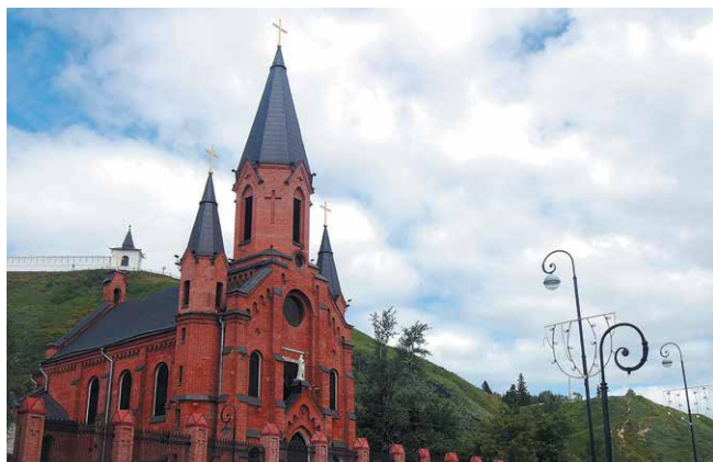
Костел Пресвятой Богородицы, г. Тобольск Общая мощность котельной — 170 кВт
