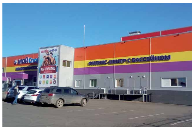
Фитнес-центр «Мой спорт Белоозерский» Общая мощность котельной — 1,5 МВт
