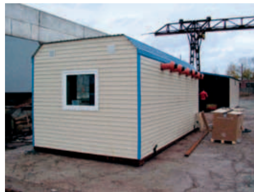
Блочная котельная в г. Улан-Удэ, работающая на сжиженном газе.
