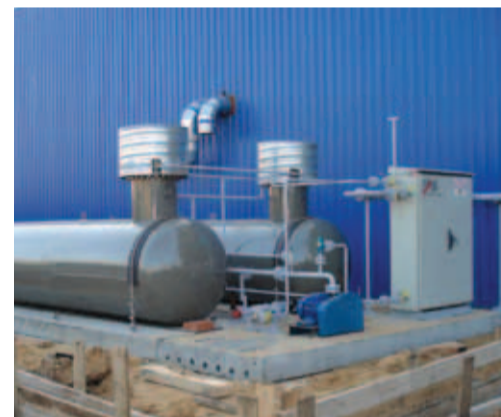
Схема газоснабжения СУГ в газгольдерах.
