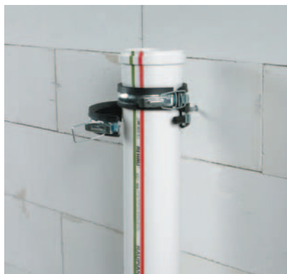
Рис. 4-3 Монтаж опорного хомута
