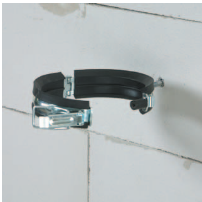
Рис. 4-1 Смонтированный опорный хомут
