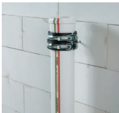
Рис. 4-4 Установленный шумопоглощающий хомут
